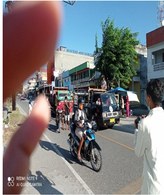
Gambar 10. Kondisi Umum jalan dekat Masjid Kamalapatih
